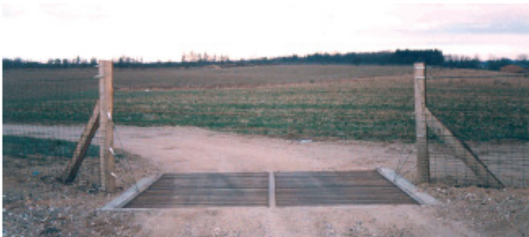
Joonis 2.6. Tee mahasõitudel võimalike ulukiretside lahendus (Wildlife And Traffic - A European Handbook For Identifying Conflicts And Designing Solutions, 2004).
